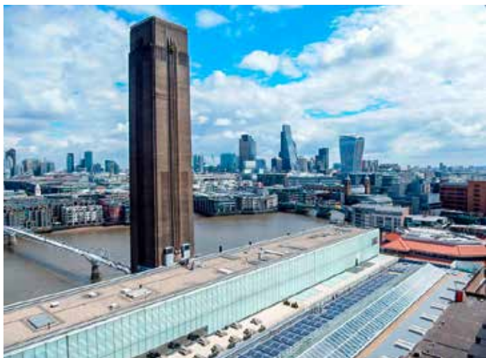
Blick vom Erweiterungsbau auf die vor 17 Jahren umgebaute ehemalige Powerstation mit dem Turm, der neuen Verglasung, den Solarpanels sowie auf Norman Fosters filigrane Millennium Bridge über die Themse
