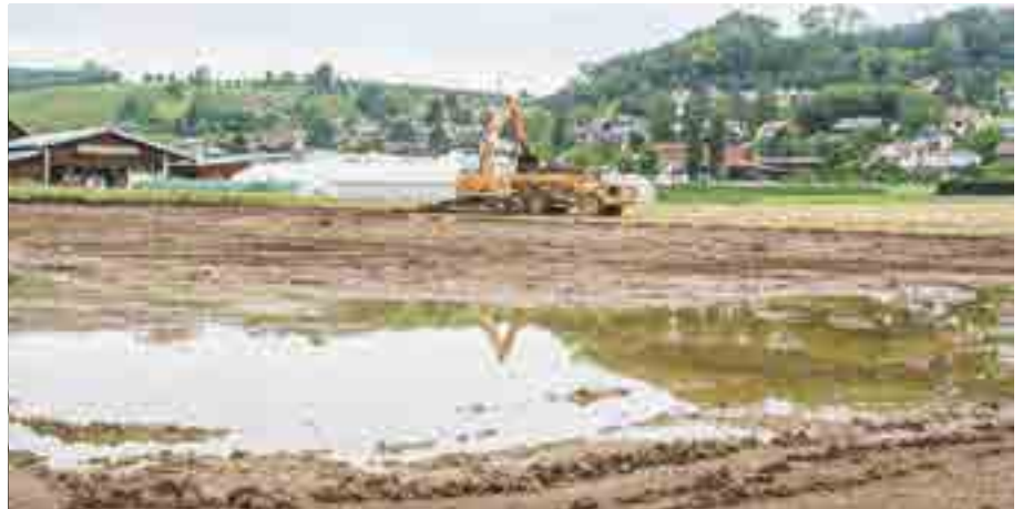
Beginn der Bauarbeiten zum neuen Sportplatz (Foto Urs Berger, 24. August 2018)
