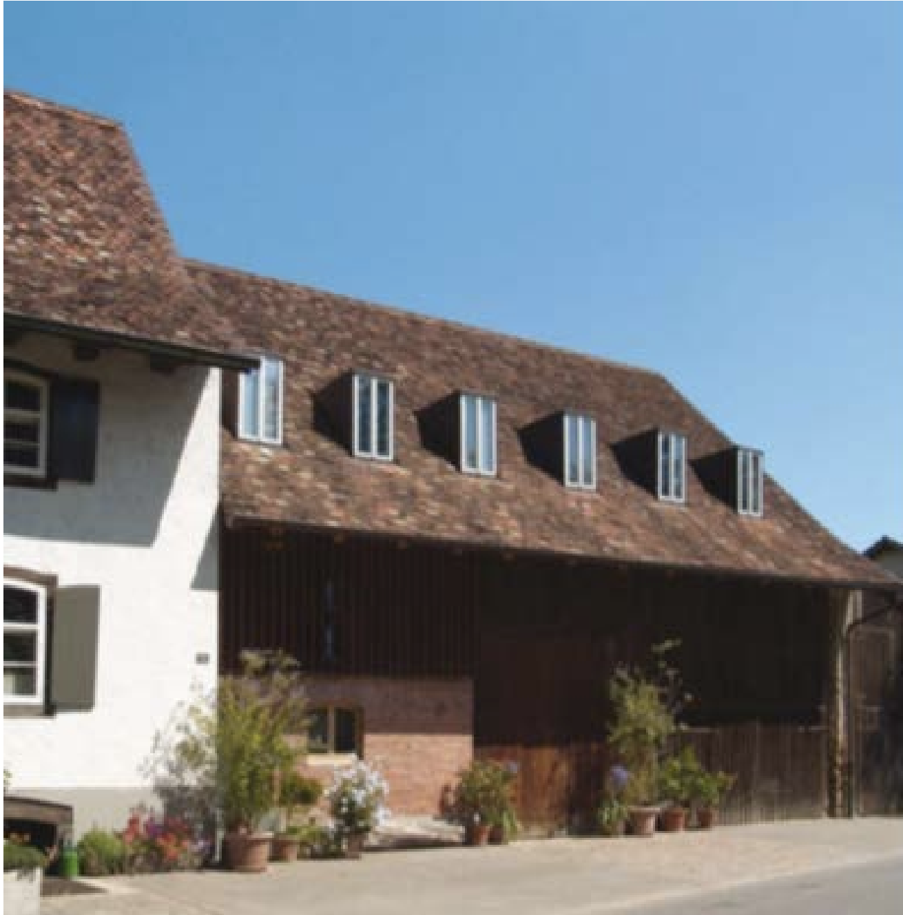
Abbildung 8: Fraumattenstrasse 1, Beispiel einer guten baulichen Qualität
