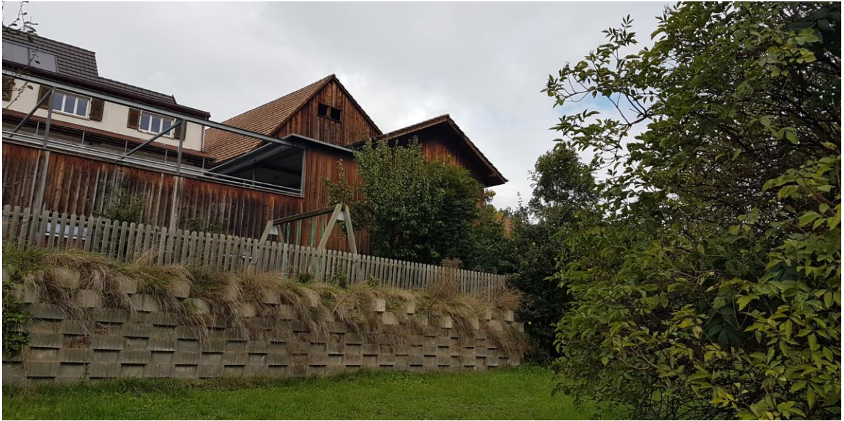
Abb. 19: Aufnahmestandort Grünfläche Parzelle Nr. 3643 mit Blick Richtung Anbau Gebäude Parzelle Nr. 45 (Quelle: Jermann AG)
