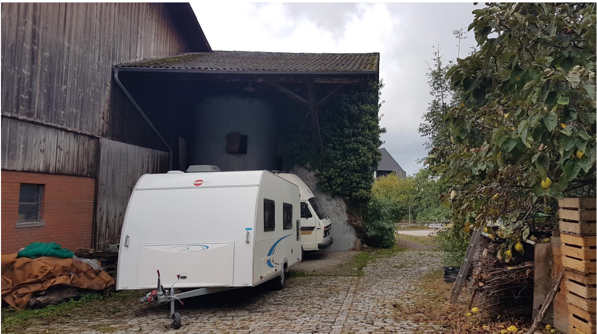
Abb. 12: Aufnahme Nordfassade Gebäude Parzelle Nr. 3643 (Quelle: Jermann AG)
