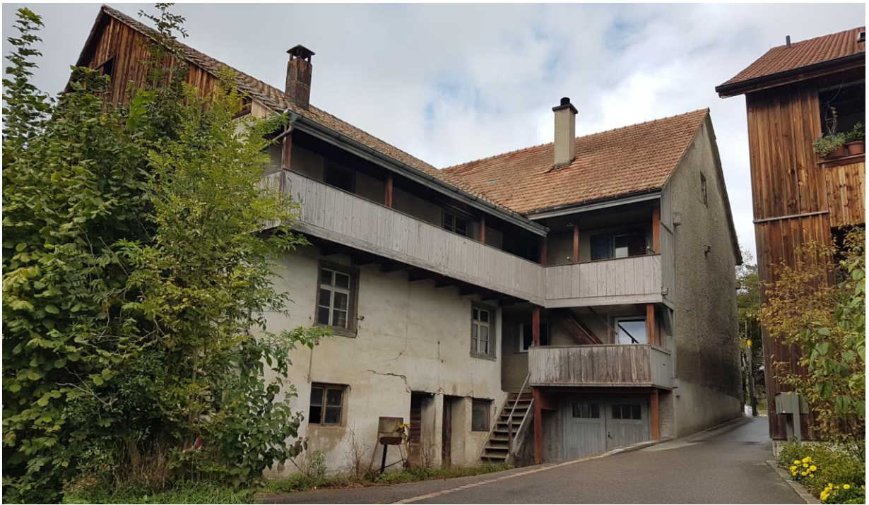
Abb. 15: Aufnahme Süd- und Ostfassade Gebäude Parzelle Nr. 45 (Quelle: Jermann AG)
