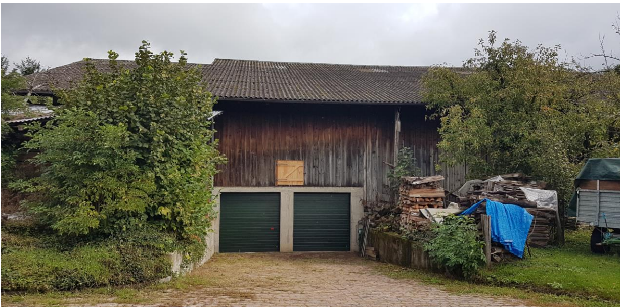
Abb. 10: Aufnahme Westfassade Gebäude Parzelle Nr. 3643 (Quelle: Jermann AG)
