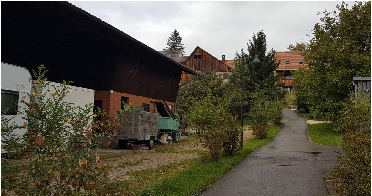
Abb. 14: Aufnahme Ostfassade Gebäude Parzelle Nr. 3643 mit Blick Richtung Südfassade Gebäude Parzelle Nr. 45 (Quelle: Jermann AG)
