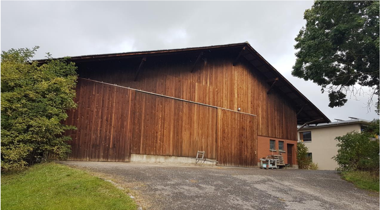
Abb. 9: Aufnahme Südfassade Gebäude Parzelle Nr. 3643 (Quelle: Jermann AG)
