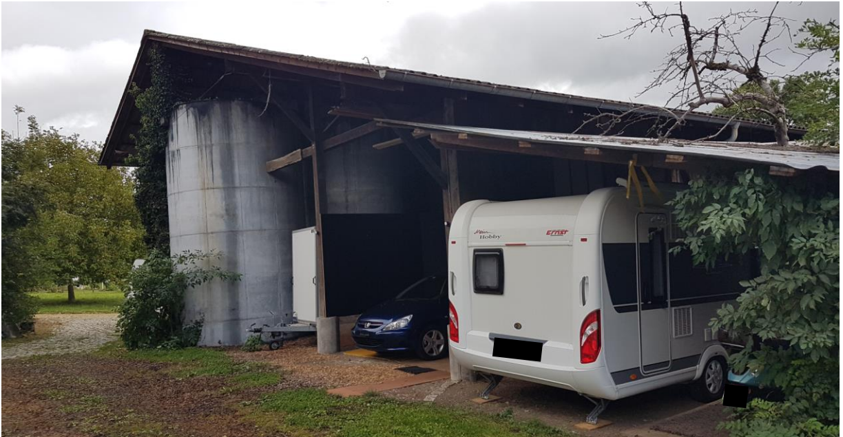
Abb. 11: Aufnahme Nordfassade Gebäude Parzelle Nr. 3643 (Quelle: Jermann AG)
