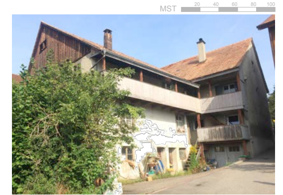
Der südliche Anbau weicht einem Ersatzneubau.
