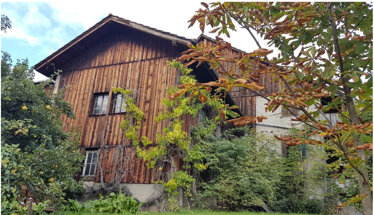
Abb. 18: Aufnahme Südfassade Gebäude Parzelle Nr. 45 mit Anbau (Quelle: Jermann AG)
