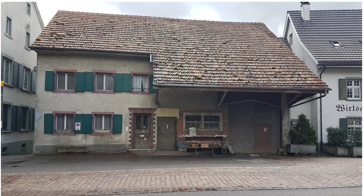
Abb. 16: Aufnahme Nordfassade Gebäude Parzelle Nr. 45 (Quelle: Jermann AG)
